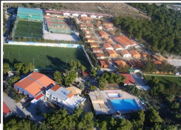
Σύγχρονες Αθλητικές εγκαταστάσεις
